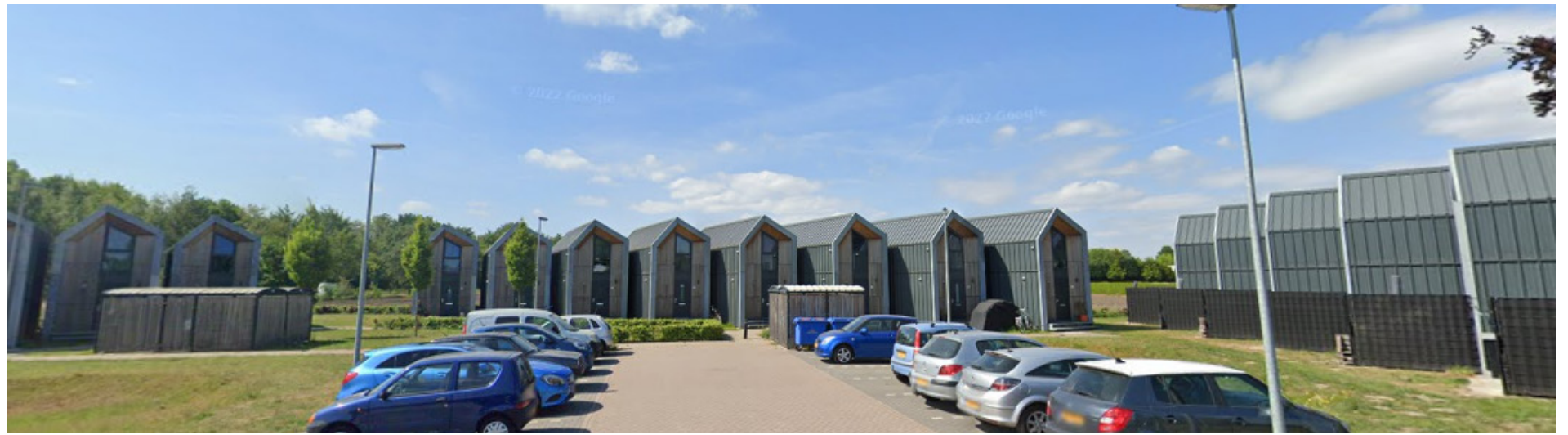
de te verplaatsen flexwoningen aan Djept Veldhoven
