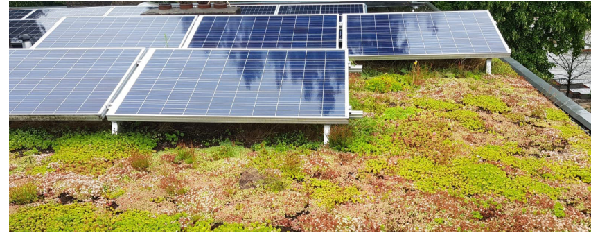
Figuur 14: Groendak met zonnepanelen
