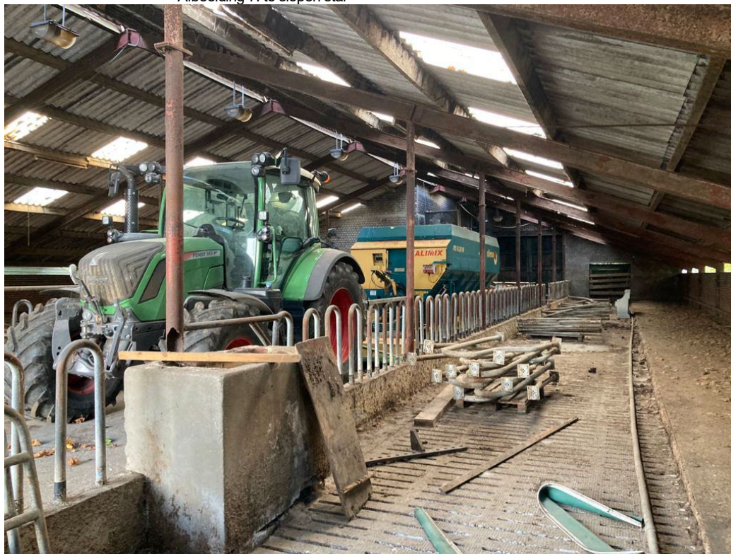
• Afbeelding 7: te slopen stal
