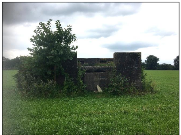
Foto 10. Bunker (oosten gebied B)
