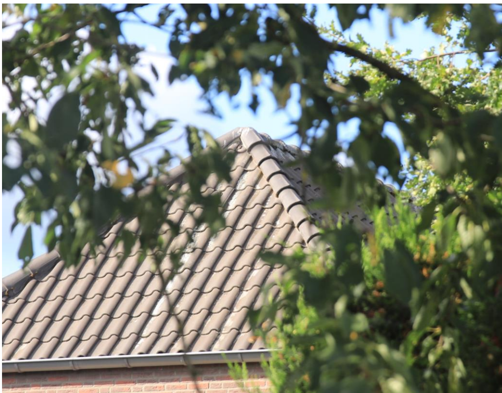
Foto 4: kalksporen op de hoekpannen in de nok verraden vaak de aanwezigheid van uilen in een gebied
