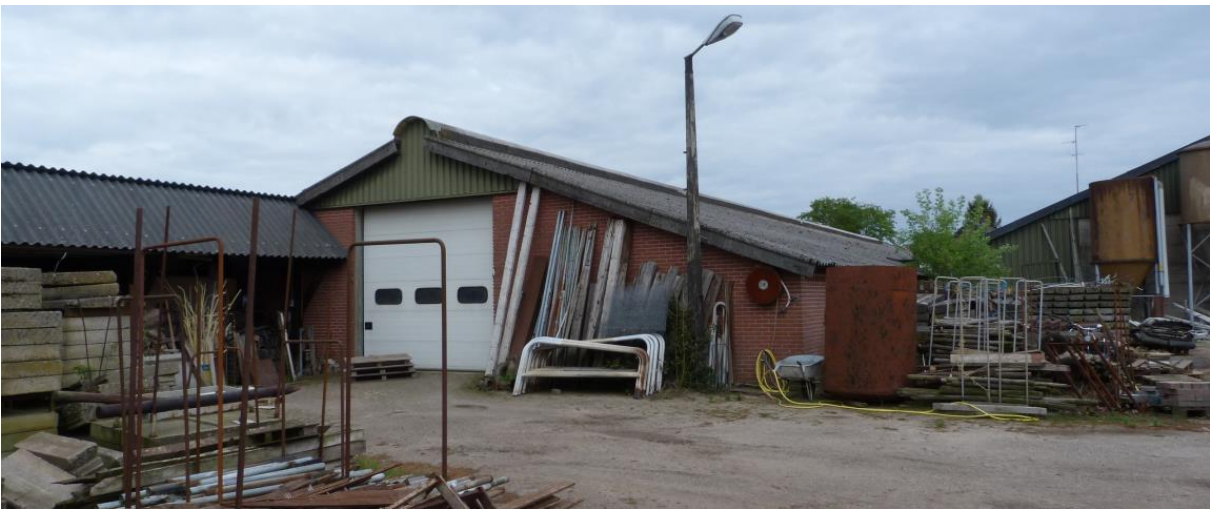
Afbeelding 8: Impressie gedeelte met gebouwen. Open kapschuur, gebouw zonder spouwmuur of dakbeschoot.
