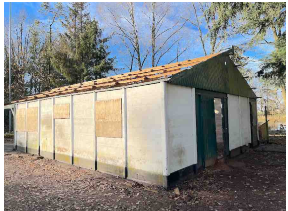
Figuur 4. Voormalig facilitair gebouw in het noorden van het park.
