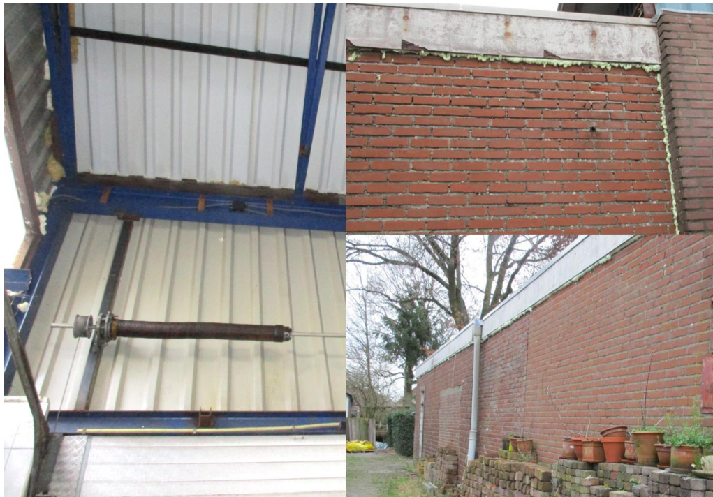
Figuur 4 De loods en de kieren tussen het boeiboord en de stenen muur zijn volledig gedicht met purschuim.
