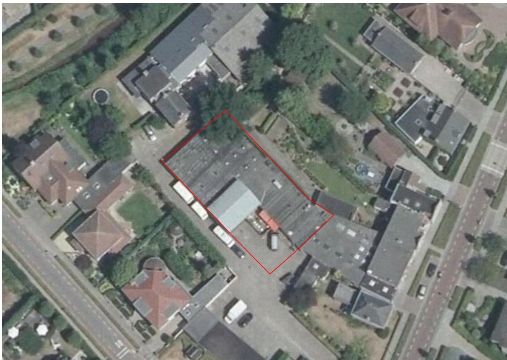
Figuur 1 De planlocatie (rood omkaderd) is gelegen aan de Pegbroekenweg ong. te Veldhoven (bron kaartmateriaal: arcgis.com).
