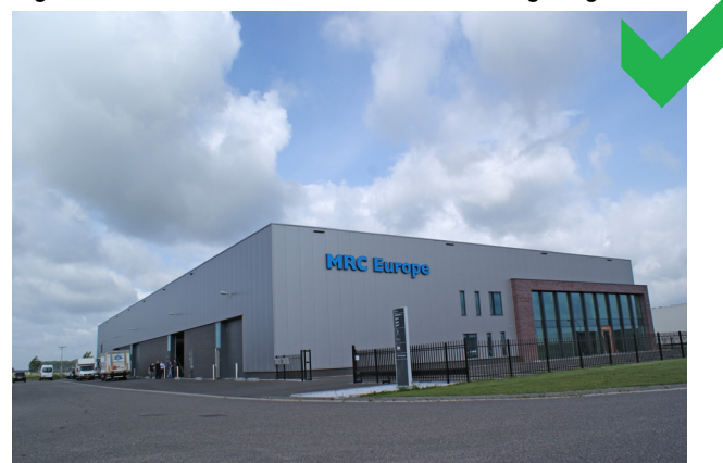
Figuur 34: Bedrijfsnaam op de gevel, rustig voorterrein
