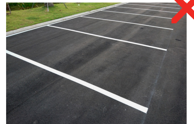
Figuur 44: Geen geasfalteerde parkeervakken
