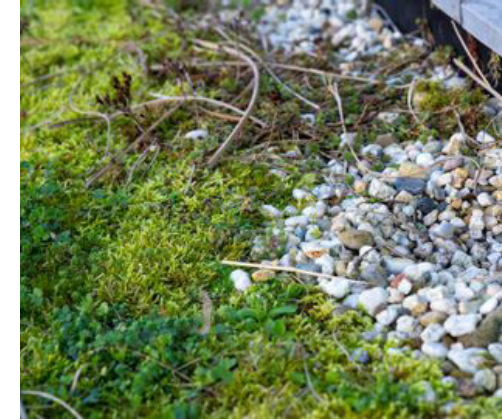
Figuur 70: Dak met grind en groen als vogelbroedplaats
