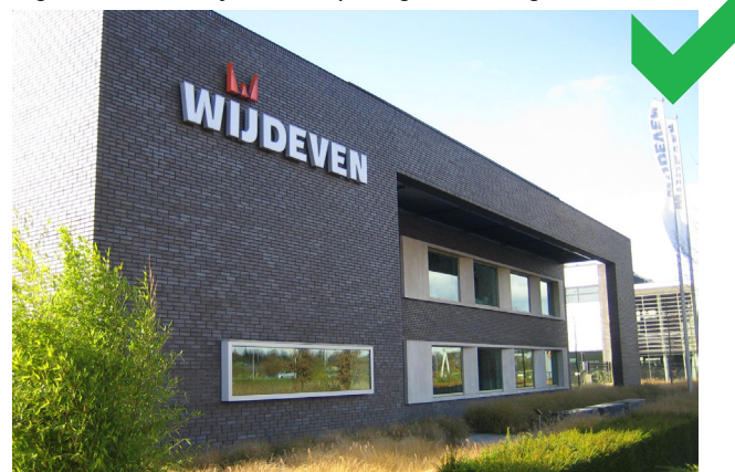
Figuur 36: Bedrijfsnaam op de gevel, rustig voorterrein
