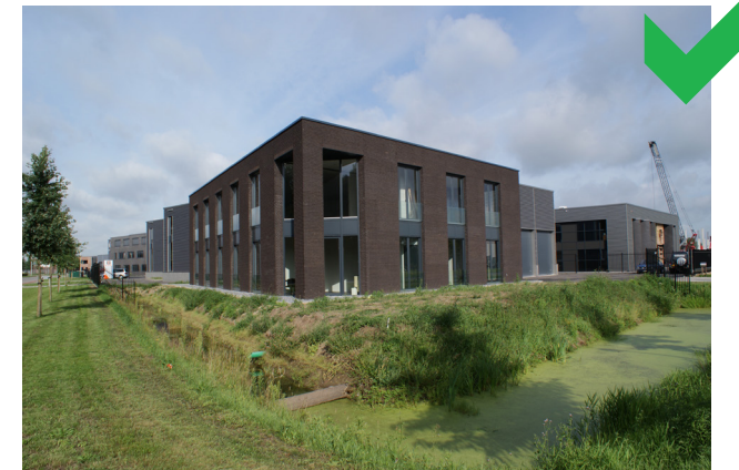
Figuur 18: Baksteen als hoofdmateriaal
