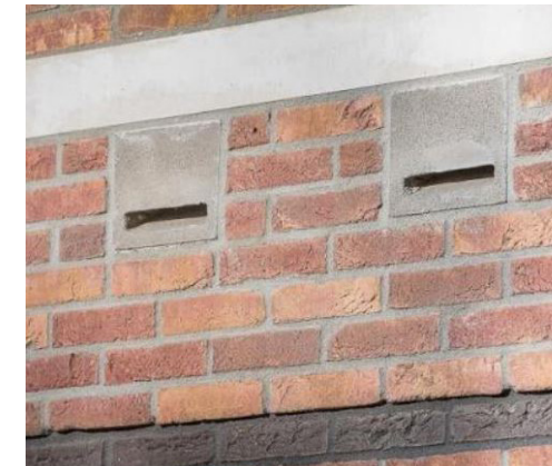
Figuur 77: Toegankelijke spouwmuur vleermuizen
