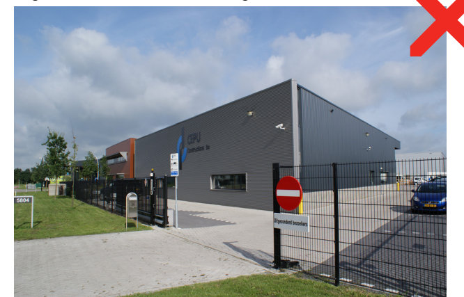
Figuur 49: Staalmathekwerk alleen aan zij- en achterkanten
