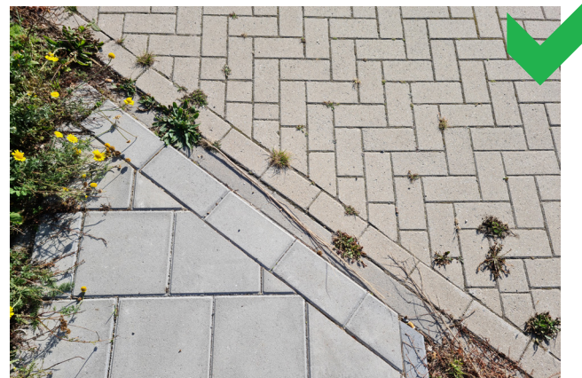
Figuur 40: Bestrating in keperverband
