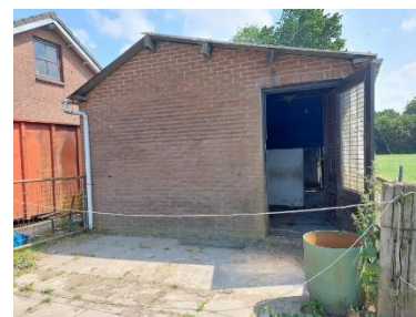
Figuur 2.10 Paardenstal noordgevel.
