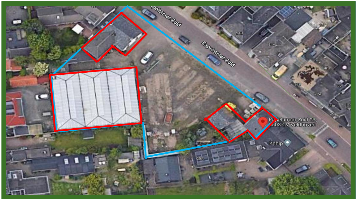
Globaal omliggende planlocatie in blauw. Te slopen bebouwing rood omkaderd.. Bron: Google Earth.
