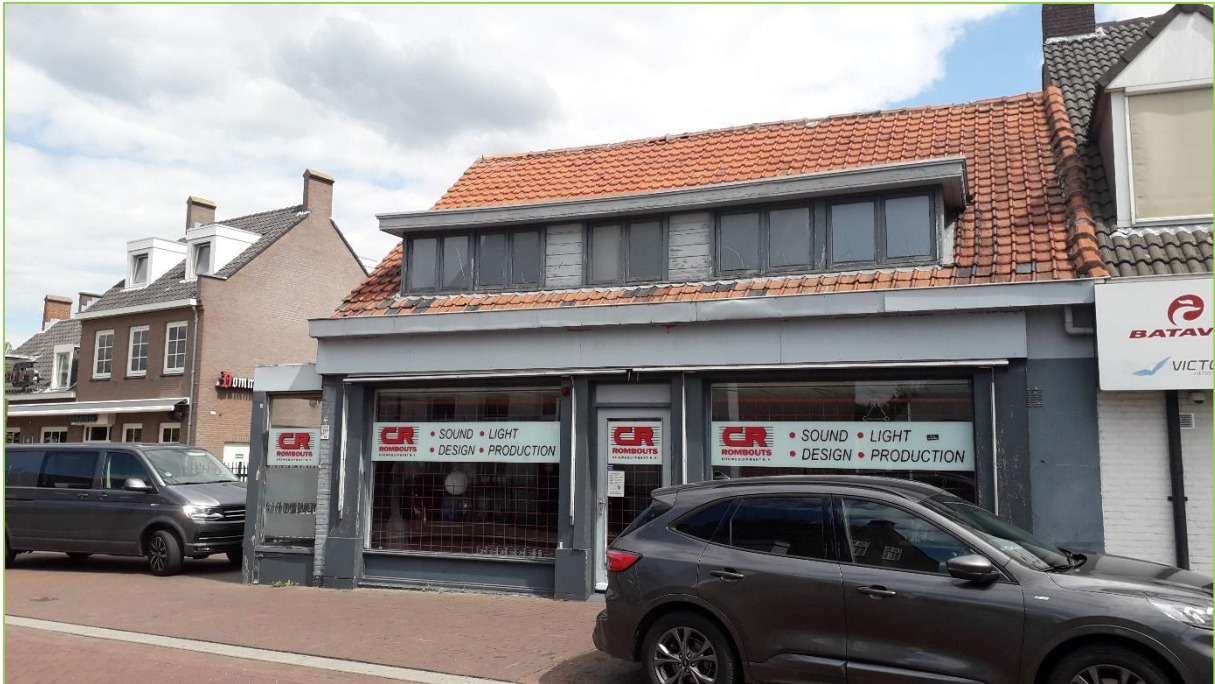
Het projectgebied betreft onder andere een winkel met diverse aanbouwen aan de Kruisstraat 6-8 te Veldhoven
