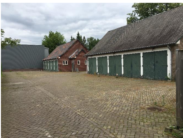
Foto 7 : Twee voormalige munitiedepotgebouwen
