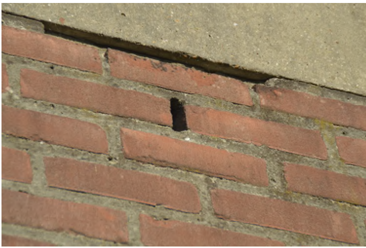
muuropeningen in zijgevel bedrijfsruimte
