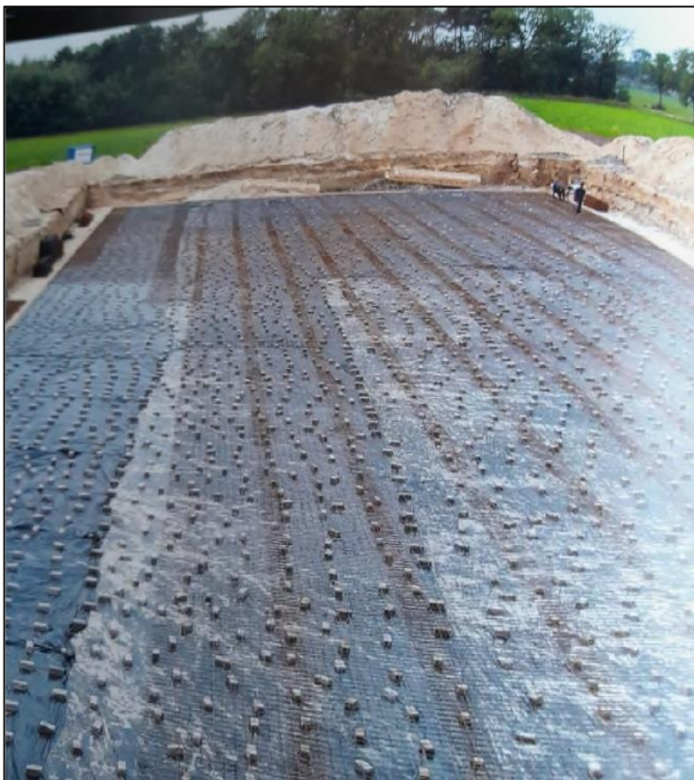
Figuur 12: Foto van de bouwput van de stal. Bron: eigenaar plangebied
