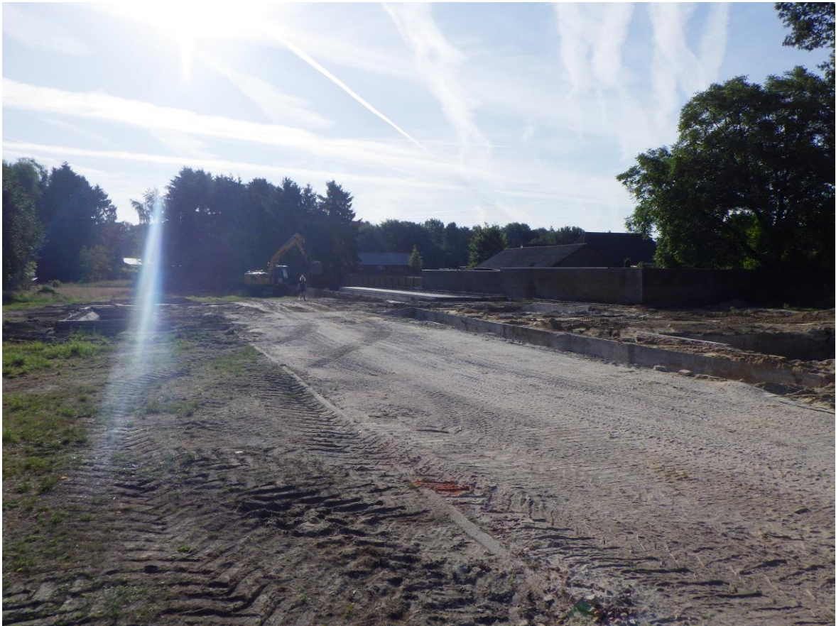
Afbeelding 1: Het plangebied vanaf Zandoerle 40 richting het oosten bij aanvang van het veldwerk. Bron: Vestigia 2022.
