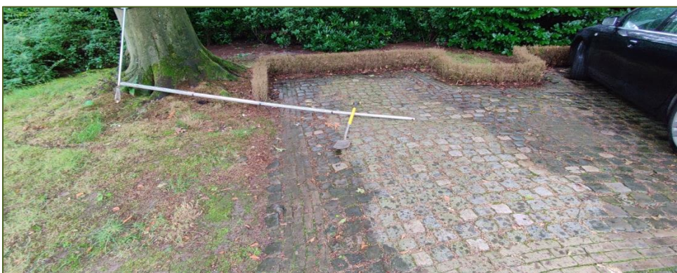
Afbeelding 6: Locatie van de sleuf, diepte van de aanwezige stabiliteitswortels en de locatie van de toekomstige muur/schutting.
