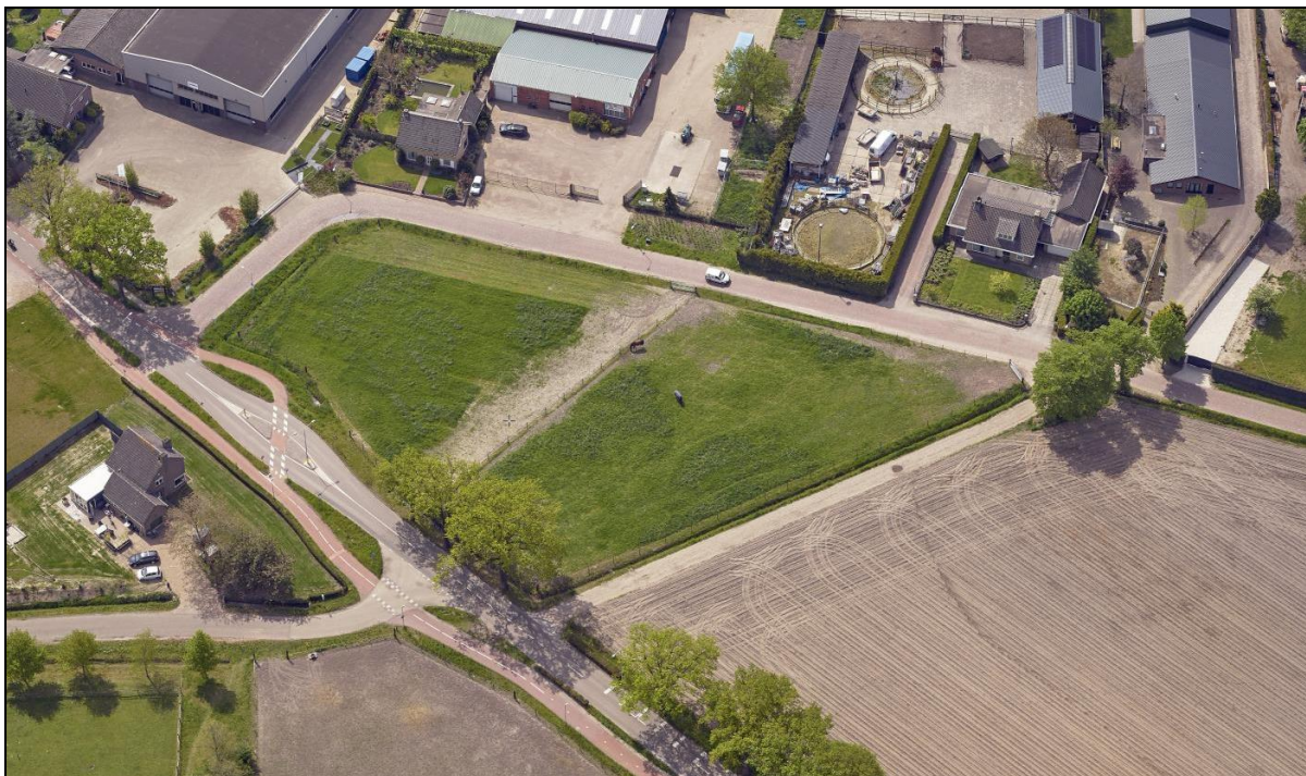
Figuur 2.1: Luchtfoto plangebied, gezien vanuit het noorden
