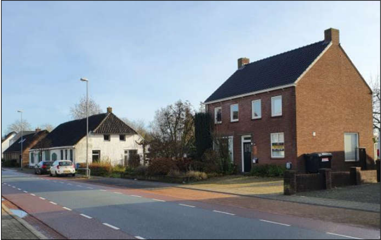
Figuur 6: Foto woningen aan Nieuwstraat 19 en Nieuwstraat 15 en 17
