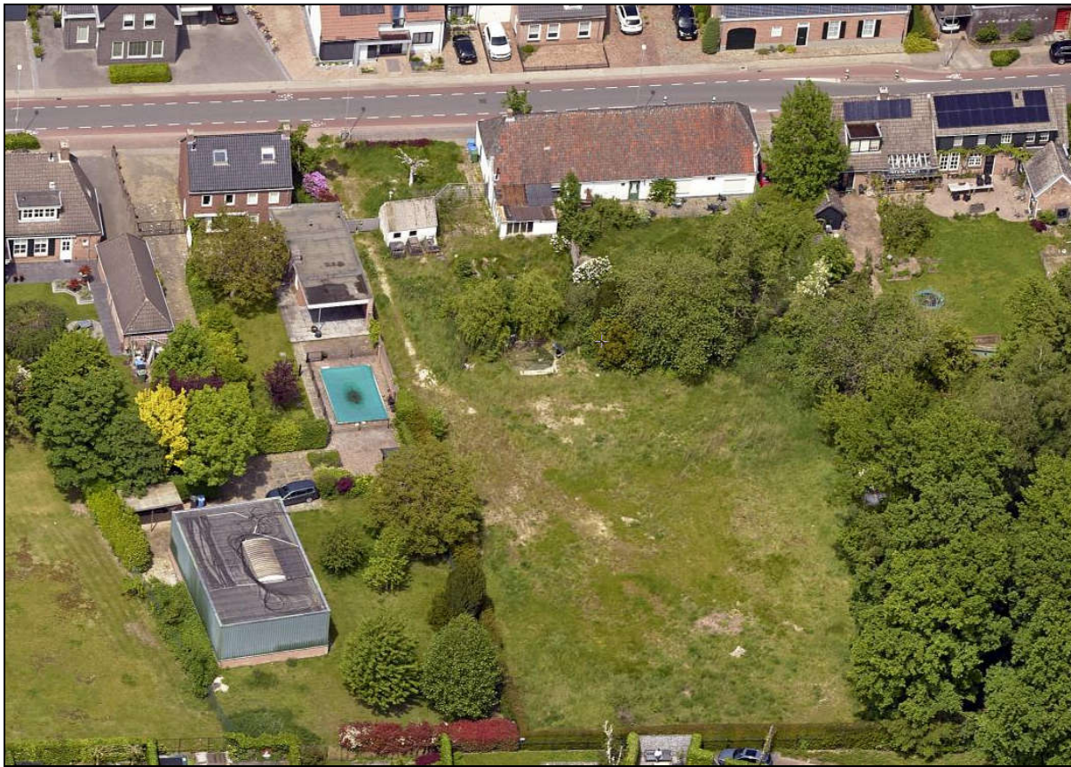
Figuur 5: luchtfoto van het plangebied in huidige situatie
