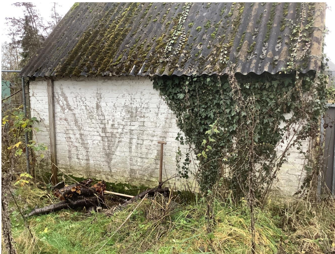
Foto van de asbestverdachte drupzone – d.d. 13 december 2021
