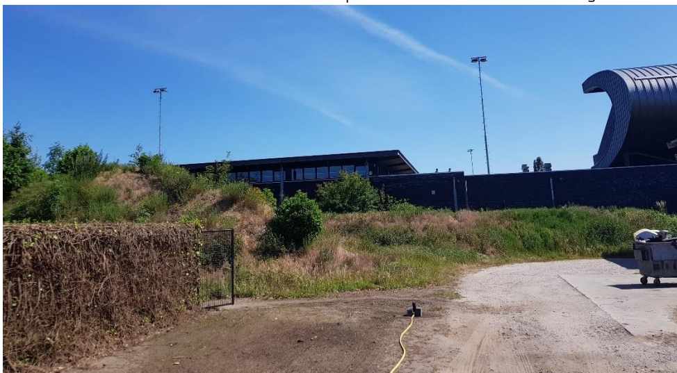
Foto 2. Terrein naast de loods met zicht op een deel van de door te trekken geluidswal
