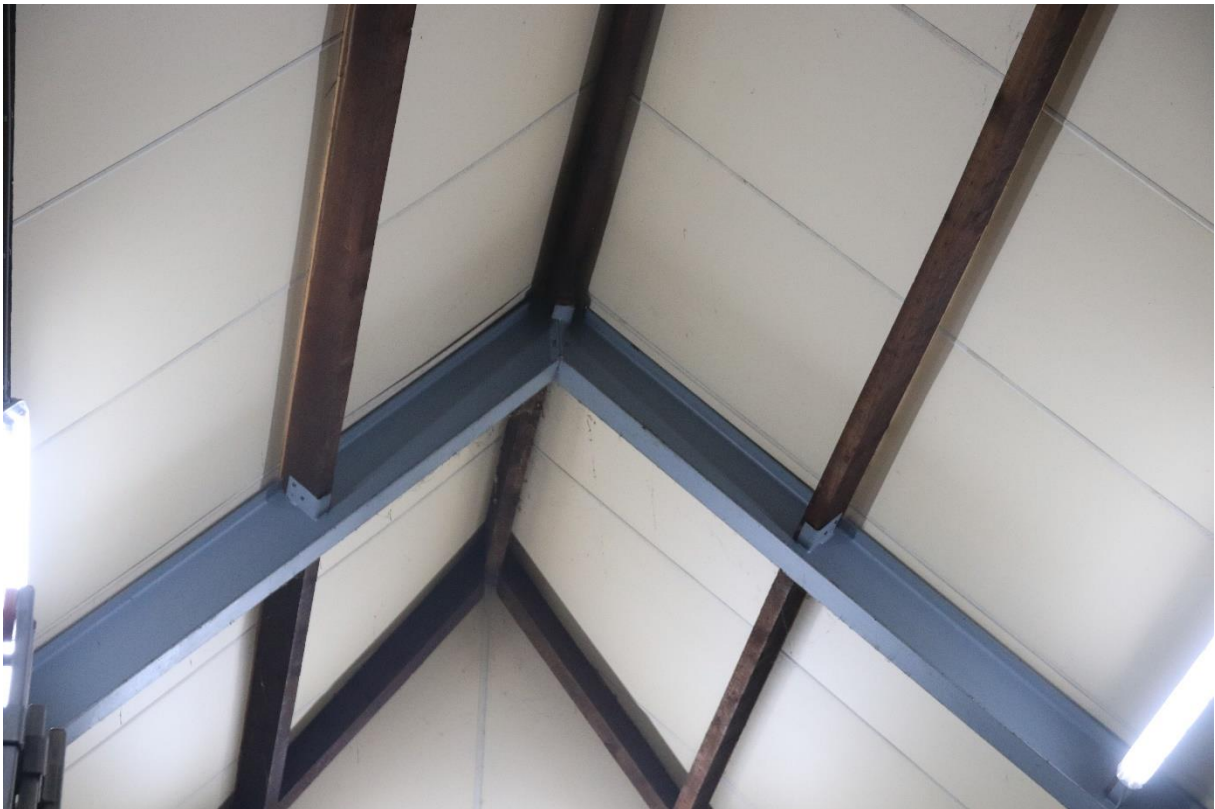
Foto 3: De binnenzijde van de loods is geheel ongeschikt als verblijfplaats voor vleermuizen (door klimaat en constructie)
