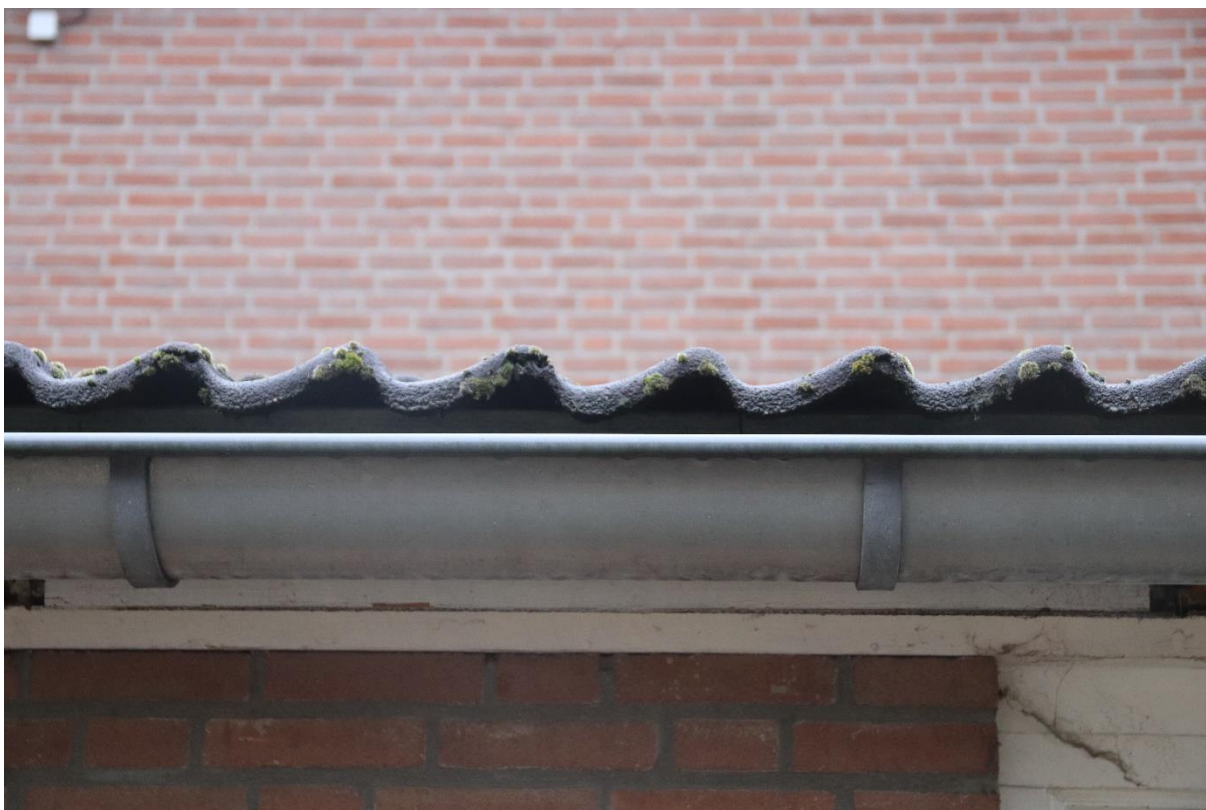
Foto 1: Onder de dakpannen is heen ruimte voor huismussen om te nesten
