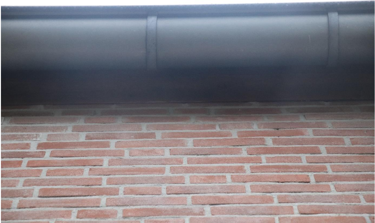
Foto 2: Er zijn nergens openingen waar vleermuizen gebruik van kunnen maken als verblijfplaats
