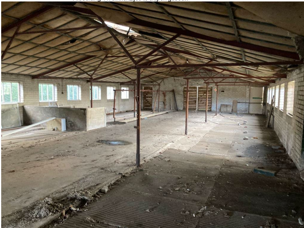
• Afbeelding 11: binnenzijde te slopen gebouw
