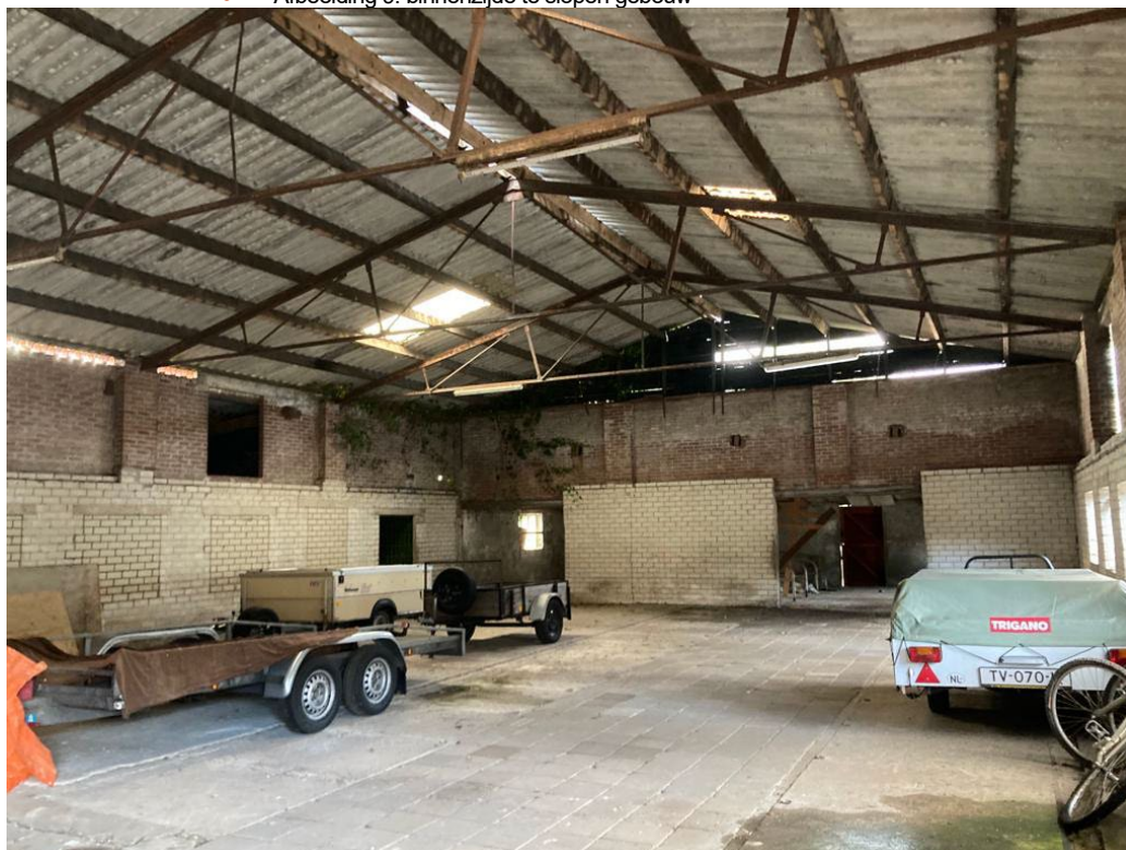
• Afbeelding 9: binnenzijde te slopen gebouw
