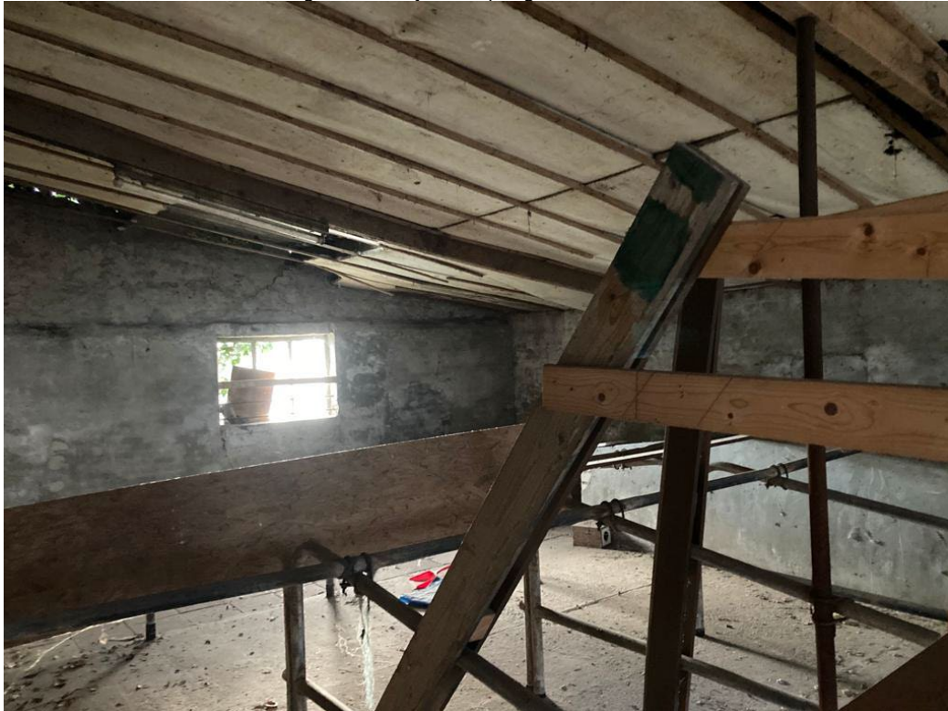
• Afbeelding 10: binnenzijde te slopen gebouw
