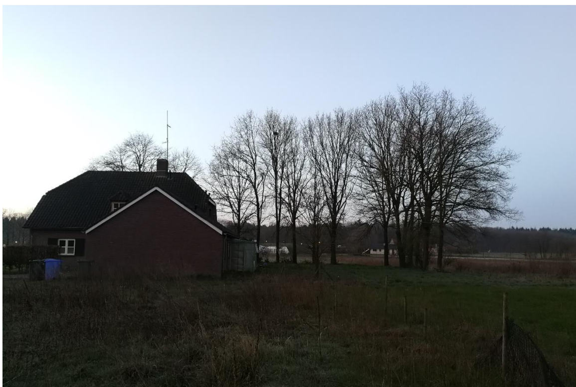
Figuur 7 Woonhuis aan Koppelenweg 7.
