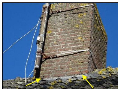
Figuur 28. Open stootvoegen (Koppelenweg 7).
