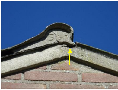
Figuur 30. Opening in kopgevel van schuur.
