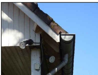
Figuur 16. Ruimte onder dakpannen (Schooterweg 41).
