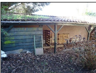
Figuur 6. Overkapping in tuin woning Koppelenweg 10.
