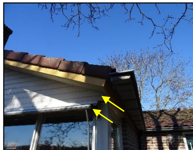
Figuur 25. Ruimte achter betimmeringen en in rolluikkast (Koppelenweg 10).
