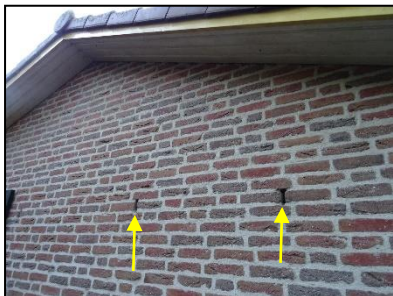
Figuur 24. Open stootvoegen (Koppelenweg 10).
