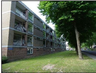
Figuur 4. Noordelijk aanzicht appartementencomplex, grasland en bomenrij.
