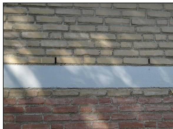
Figuur 14. Open stootvoegen flat.
