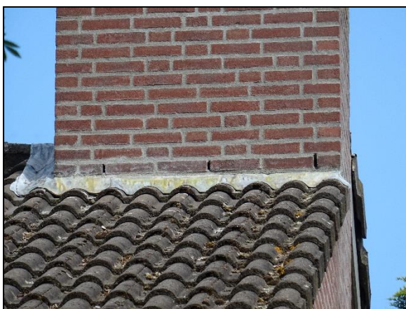
Figuur 13. Open stootvoegen woonhuis.
