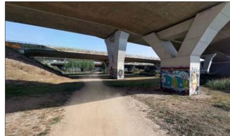
Figuur 5.7 Tunnel De Run
