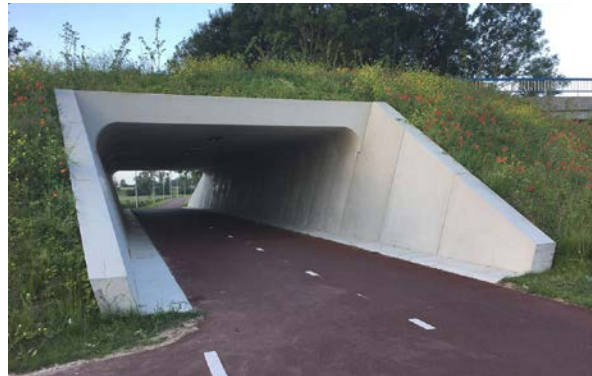
Figuur 6 Fietstunnel van prefab betonelementen
