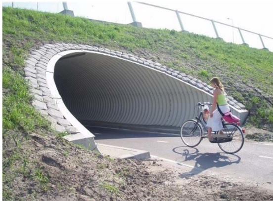
Figuur 5 Fietstunnel van gebogen golfplaten
