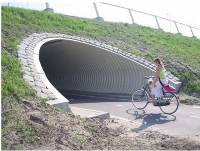
Afbeelding 13: Fietstunnel van gebogen golfplaten
