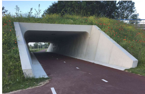
Afbeelding 14: Fietstunnel van prefab betonelementen
