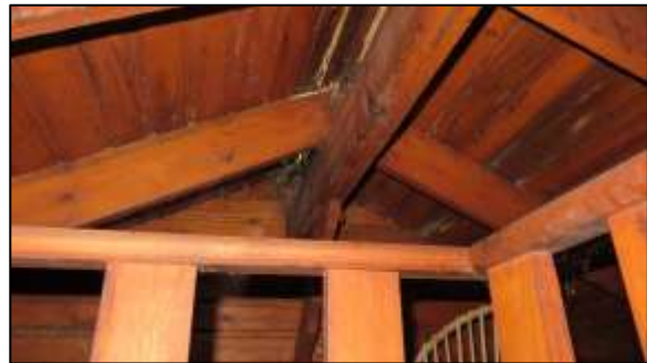
Foto 14. Opening in het dak van het tuinhuisje
