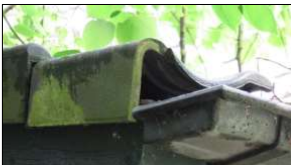
Foto 7. Open ruimte onder de dakpan van het woonhuis
