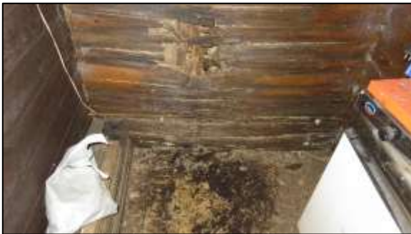
Foto 13. Opening in de muur van het tuinhuisje
