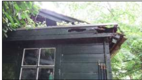
Foto 12. Opening in de dakrand van het tuinhuisje
