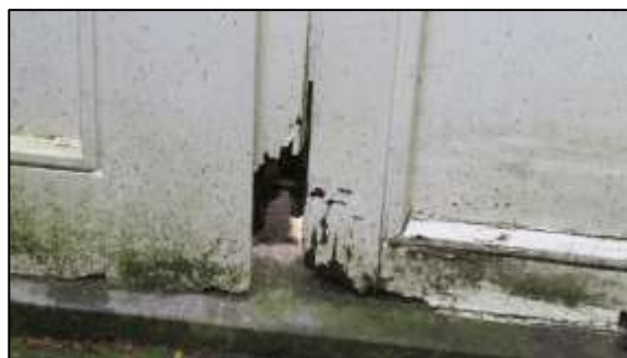
Foto 6. Opening in de serre aan het woonhuis
