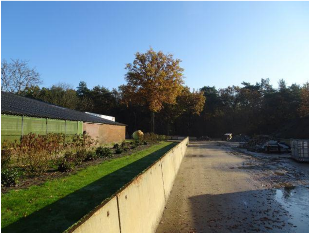
Overzicht noordelijk deel plangebied naar het oosten gezien
