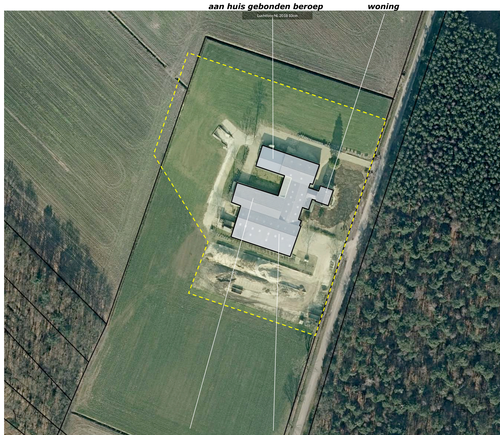
stalling privecollectie tractoren en caravans van derden
