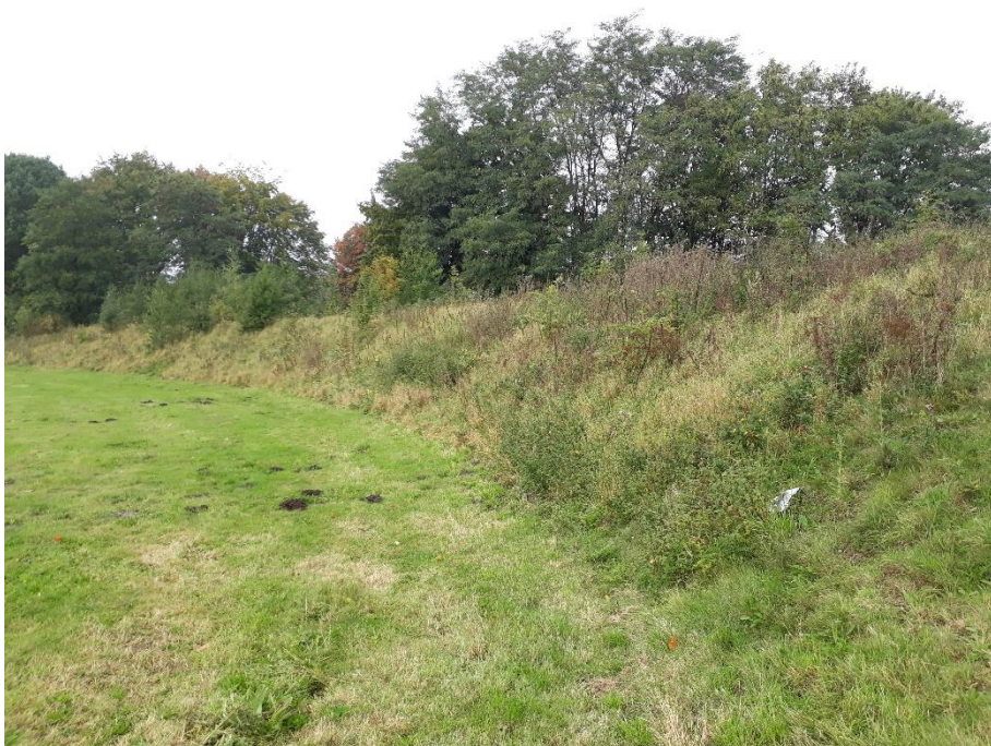
Foto 3: Talud met wat ruigere vegetatie.
