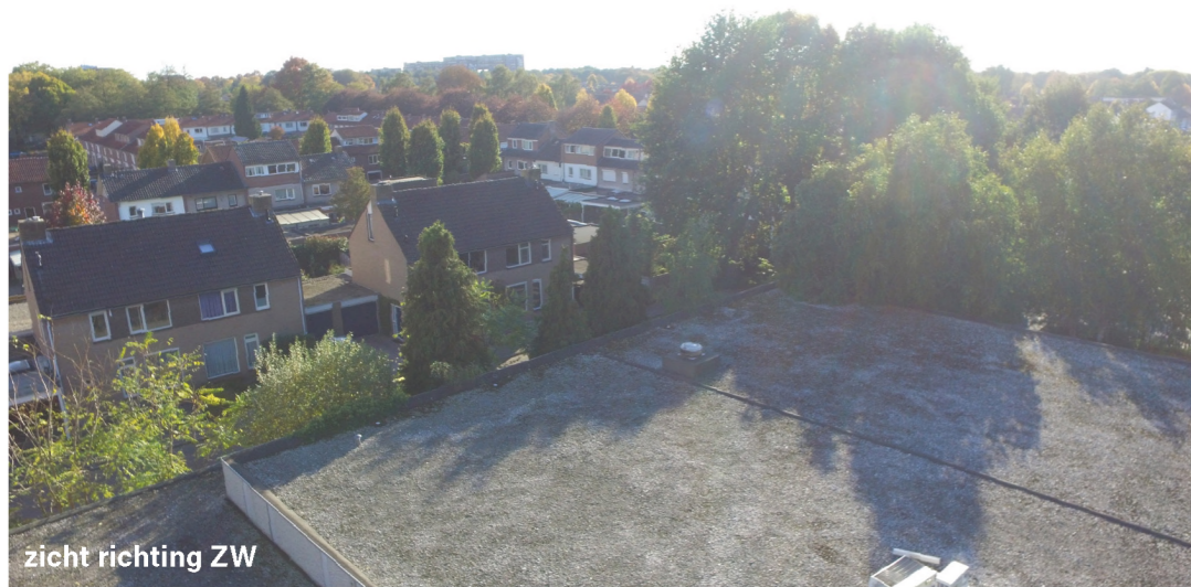
gebouw D | vanaf 12 de bouwlaag
