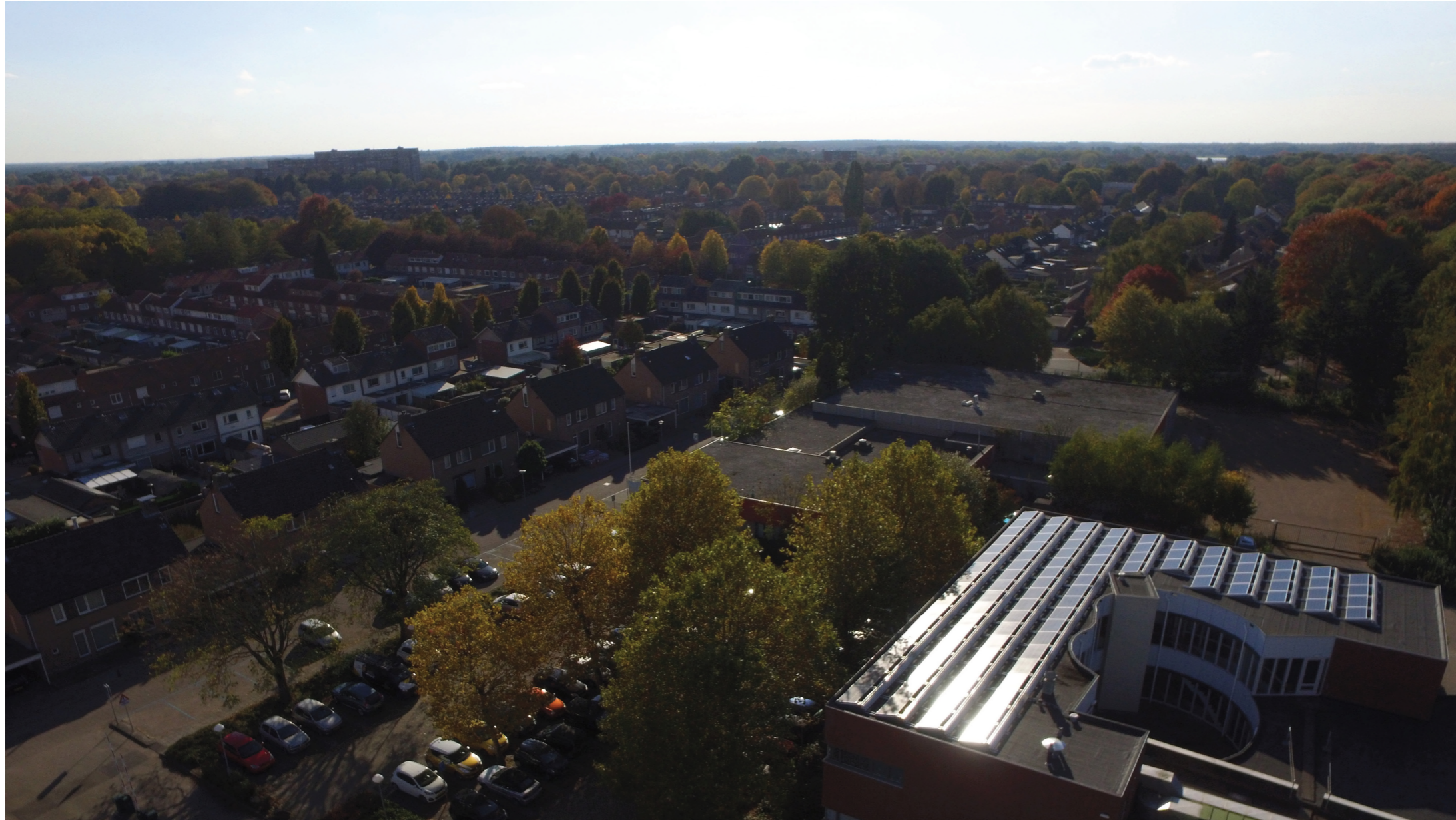
gebouw D | vanaf 12 de bouwlaag | zicht naar ZO
