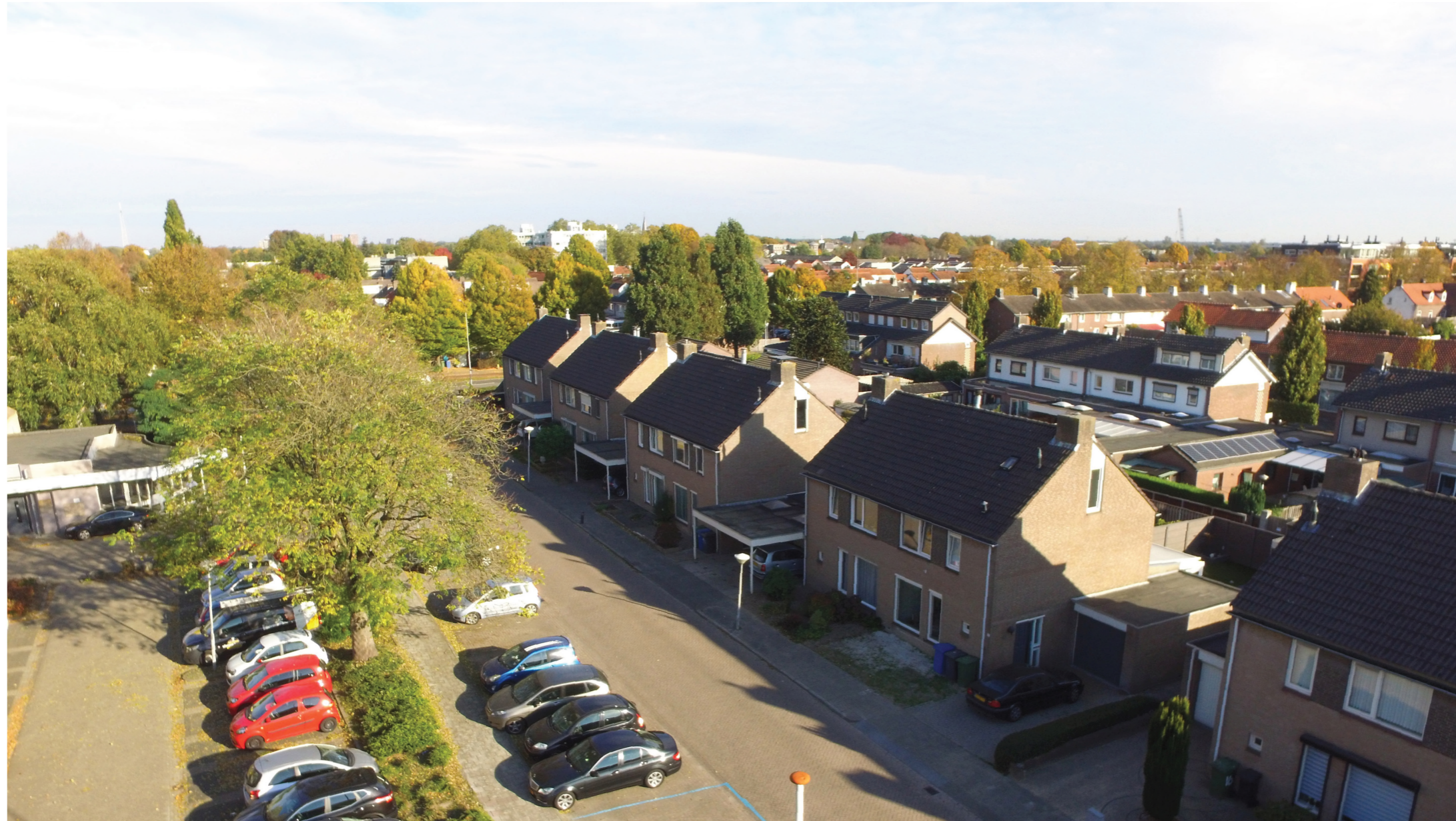
gebouw B | vanaf 4 de bouwlaag | zicht naar ZO
