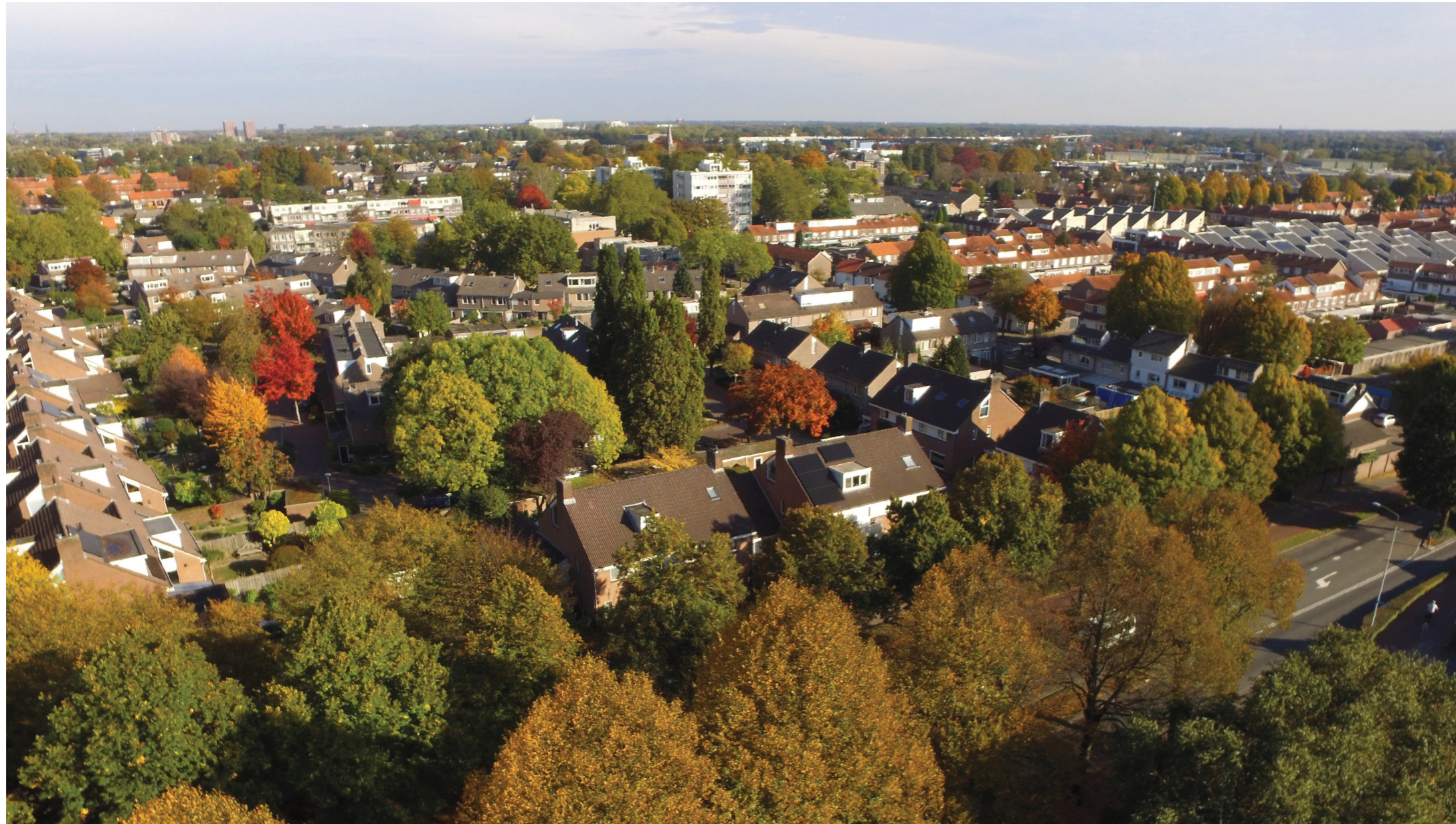
gebouw D | vanaf 12 de bouwlaag | zicht naar ZW
