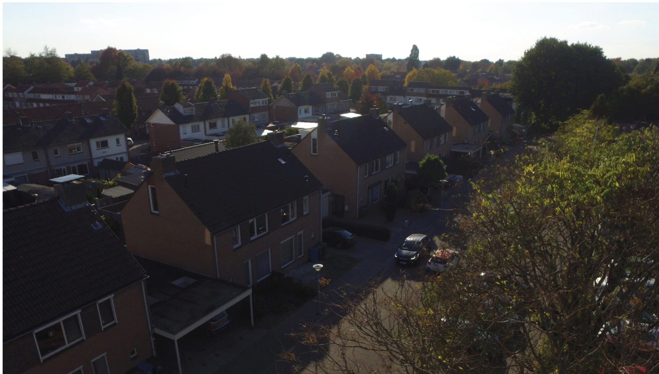
gebouw C | vanaf 4 de bouwlaag | zicht naar ZW
