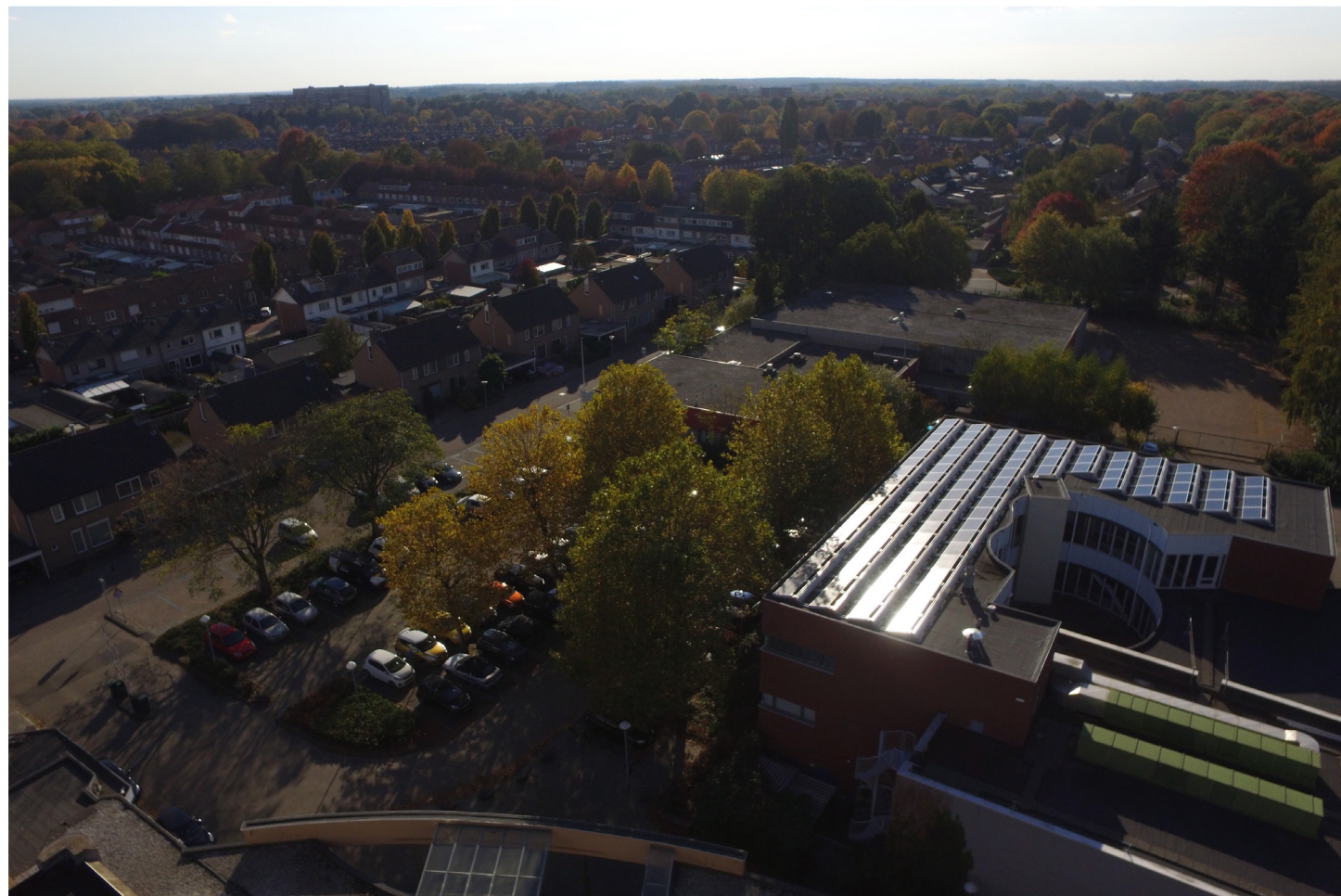
gebouw D | vanaf 12 de bouwlaag | zicht naar ZW
