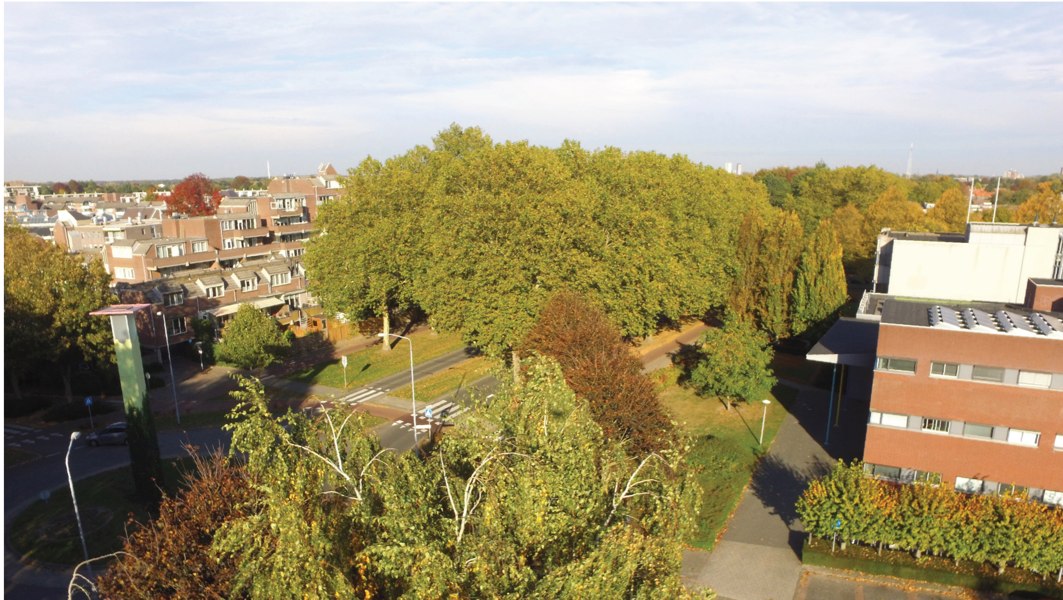
gebouw A | vanaf 6 de bouwlaag | zicht naar NO
