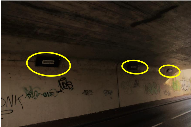
Foto 3: De onderdoorgang wordt door sterke verlichting aan weerszijden (gele cirkels) veilig gehouden voor verkeer
