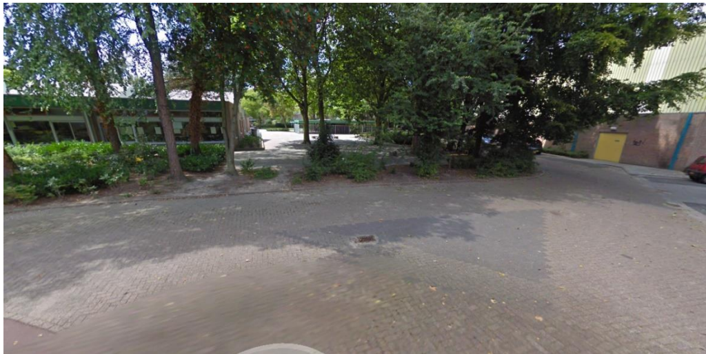
Deel achterzijde huidige zwembad en sporthal rechts en voormalige basisschool De Rank (voor de sloop van de bebouwing) links (bron: Google Maps)
