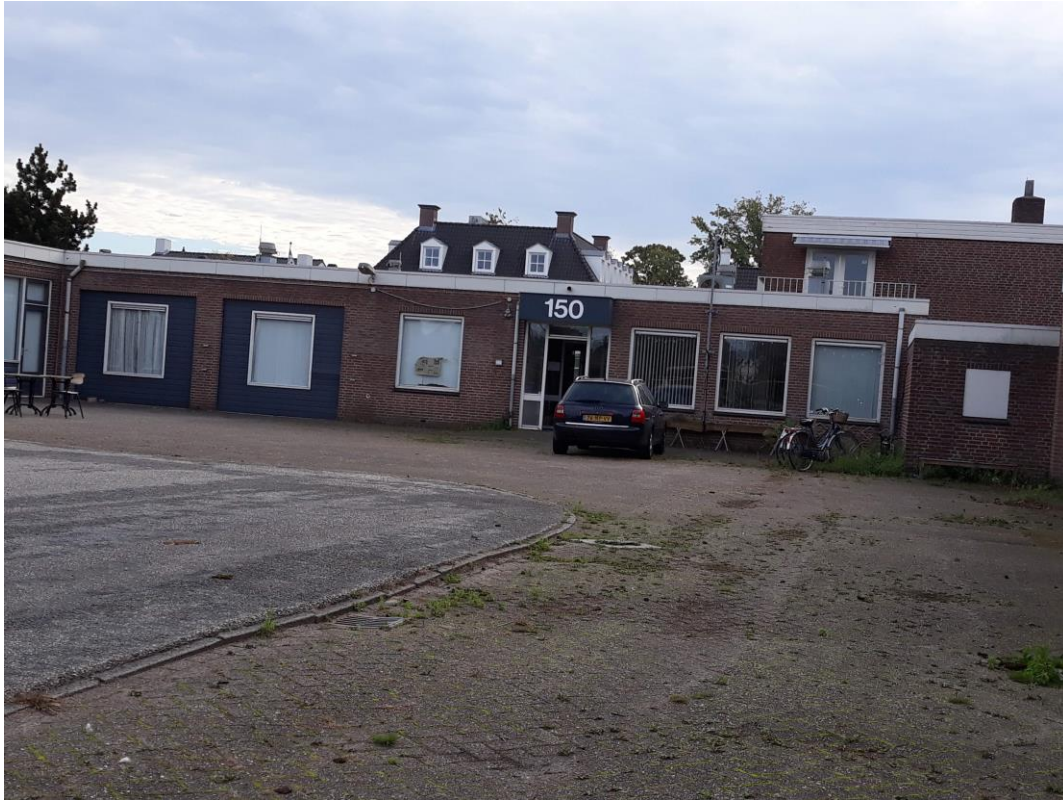
Laag en hoogbouw vanaf de noordzijde gefotografeerd:
