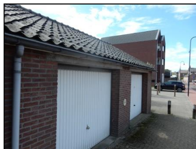
Figuur 4. Voorzijde van de garage/schuur.
