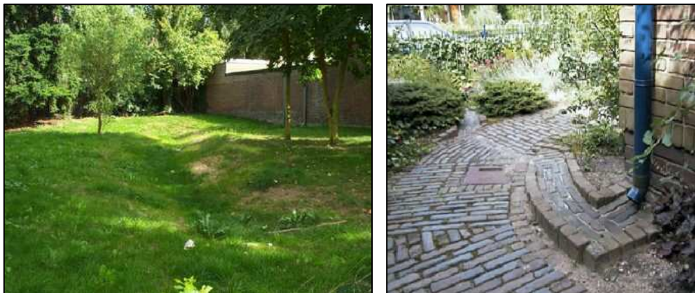
Figuur 13: Voorbeelden infiltratievoorzieningen
