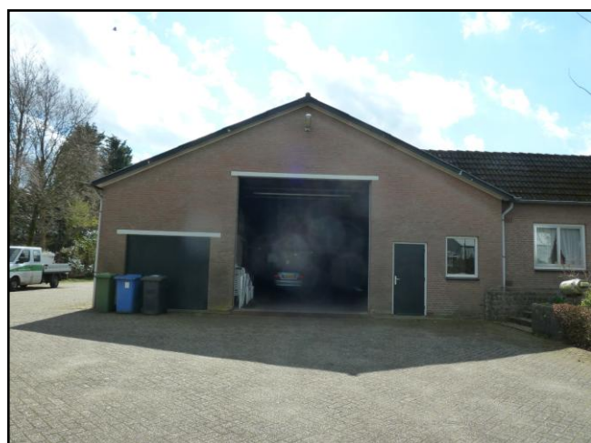
De te slopen loods
