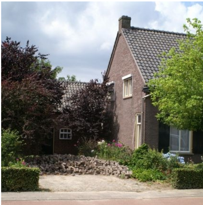
Linker zijgevel met bijgebouw
