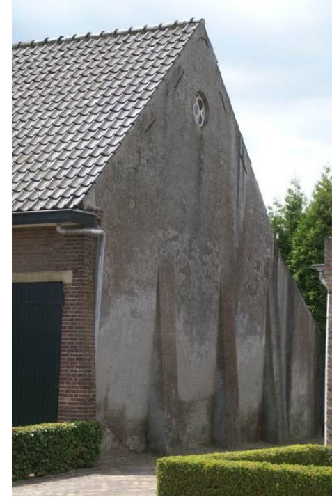
Rechter zijgevel met steunberen
