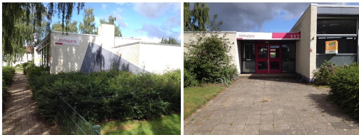
Figuren 1 en 2: Overzichtsfoto's onderzoekslocatie.
