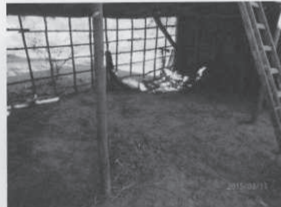
Inspectie vloer schuur
