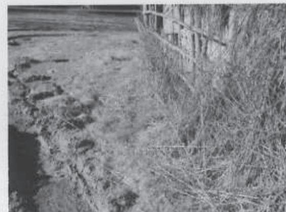
Inspectie maaiveld rondom
