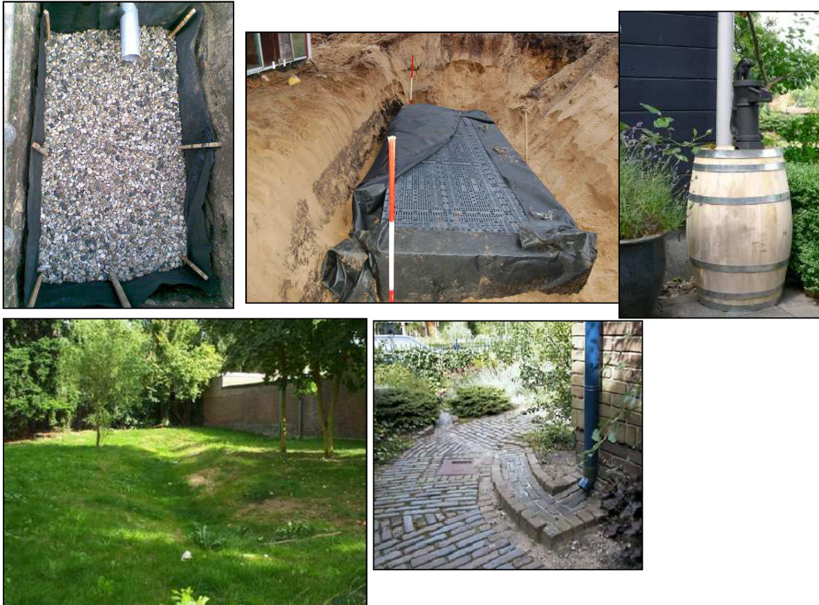
Figuur 16: Voorbeelden van infiltratievoorzieningen
