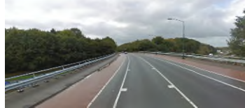
Kruising viaduct De Locht
