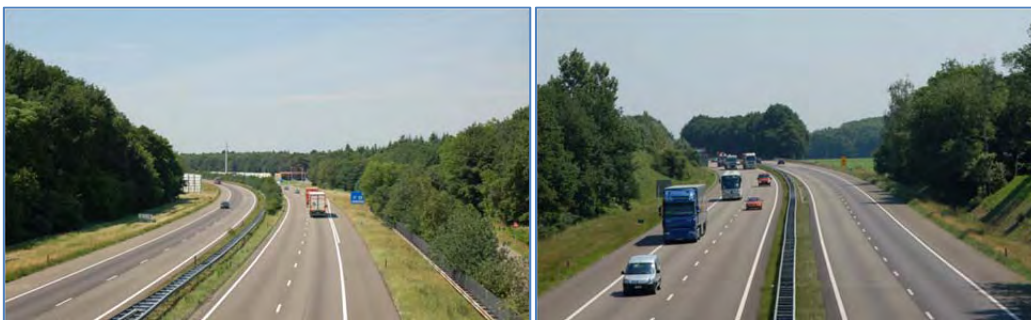
Afbeelding 87: Zicht op A67 vanaf snelwegovergang Locht in westelijke (links) en in oostelijke richting (rechts)
