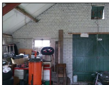
Figuur 7. Binnenkant te verwijderen schuur.
