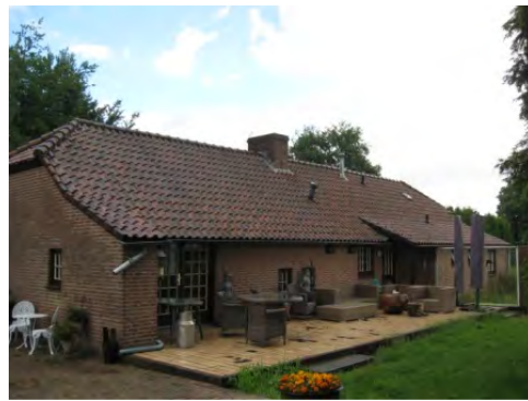
Foto 2. De woning, gezien vanuit de tuin.
