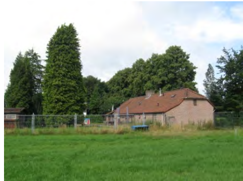
Foto 6. De woning gezien vanuit oostelijke richting.
