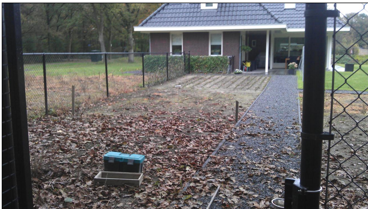
Figuur 3: deelgebied 2 bij aanvang van de werkzaamheden in oostelijke richting gefotografeerd.
